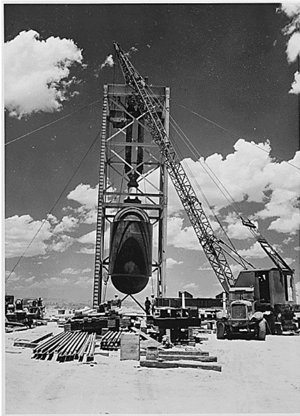
Figura 2.5: Dispositivo nuclear “Jumbo” sendo posicionado para o teste “Trinity” em Alamo-gordo, Novo México (NEIGHBORHOOD..., 2008)
